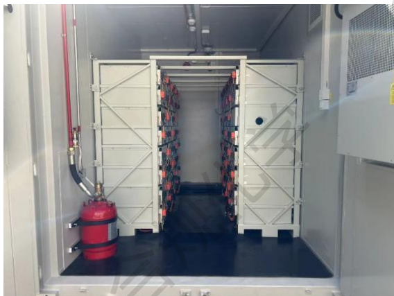
图 6 储能集装箱内部电池和设备牢固连接示例
